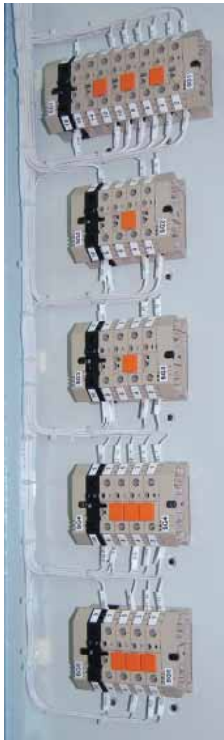
Вид со стороны монтажа
